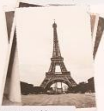
Inauguración de la torre Eiffel.
